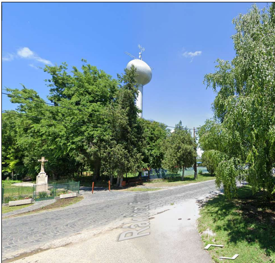
A víztoronyra szerelt, a vízügy területén lévő adó
