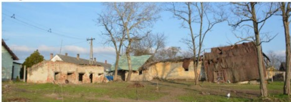
82. ábra Nyugati homlokzat, a kép bal oldalán az egykori ősi épület tömegével
