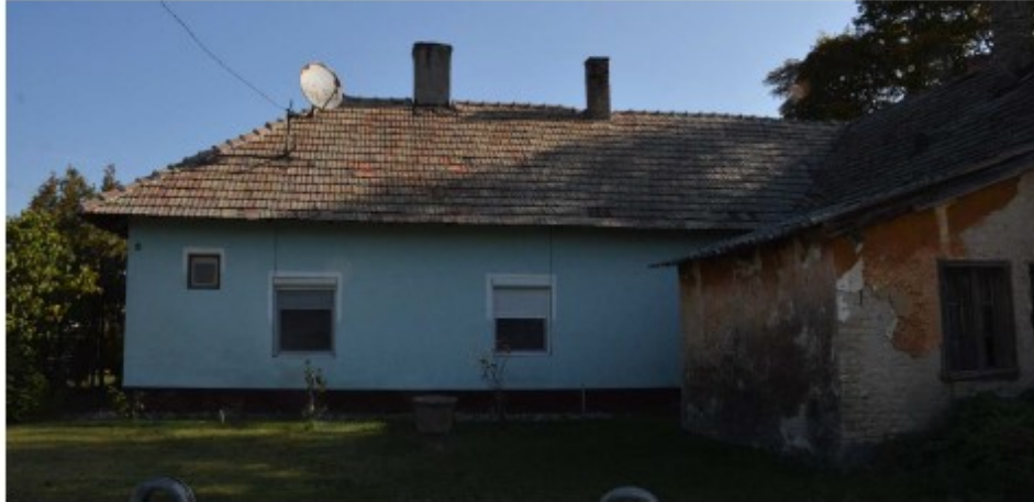
50. ábra Északi épületszárny, nyugat felől tekintve
