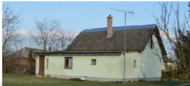
74. ábra A ház udvari homlokzata, DNY felől
