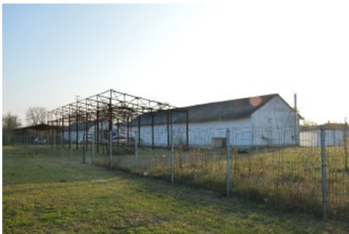
65. ábra Az északi oldali csarnok és csarnokváz
