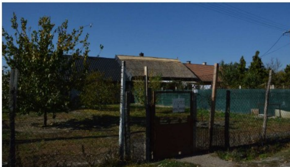
25. ábra A déli cselédház háromlakásos épületként működik jelenleg (2019. október)
