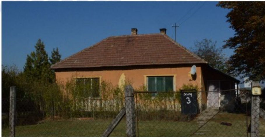
56. ábra A 072/14 hrsz alatti lakóház déli irányból
