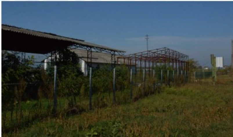
64. ábra Az északi csarnokváz és a csarnok a háttérben balra
