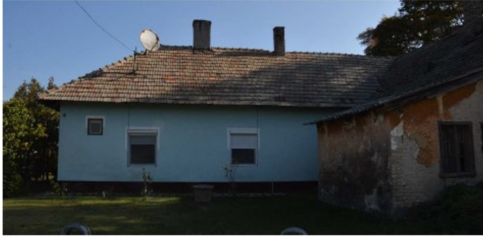
50. ábra Északi épületszárny, nyugat felől tekintve
