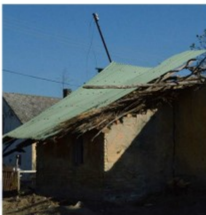
86. ábra A nyugati homlokzathoz toidott, de elvált épületrész
