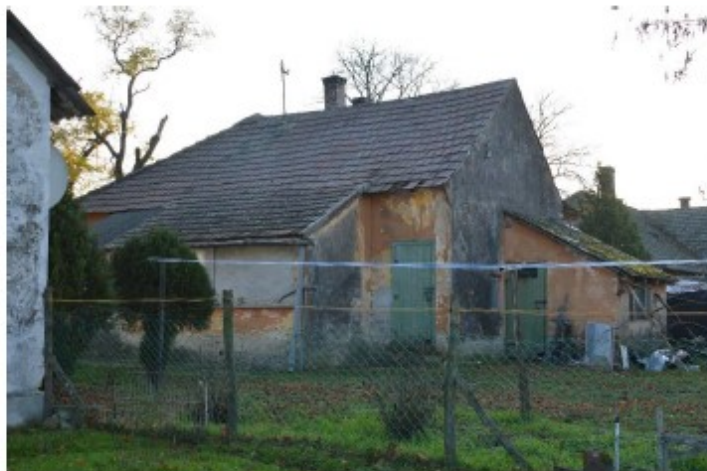
57. ábra Az épület hátsó homlokzatrészelet EK felől
