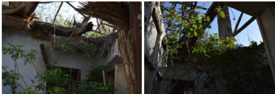
37. ábra Az északi épületrész belsége közepén
