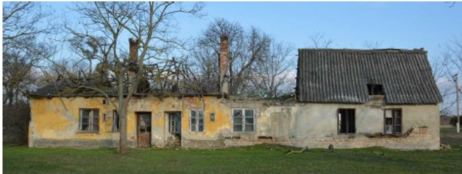
33. ábra Nyugati homlokzat
