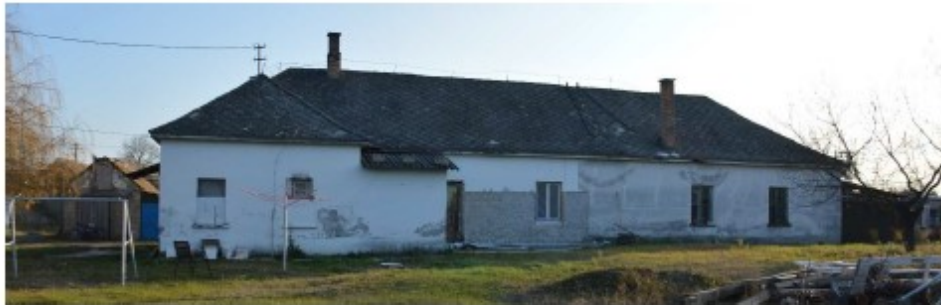
72. ábra A lakóház északi (hátsó) homlokzata
