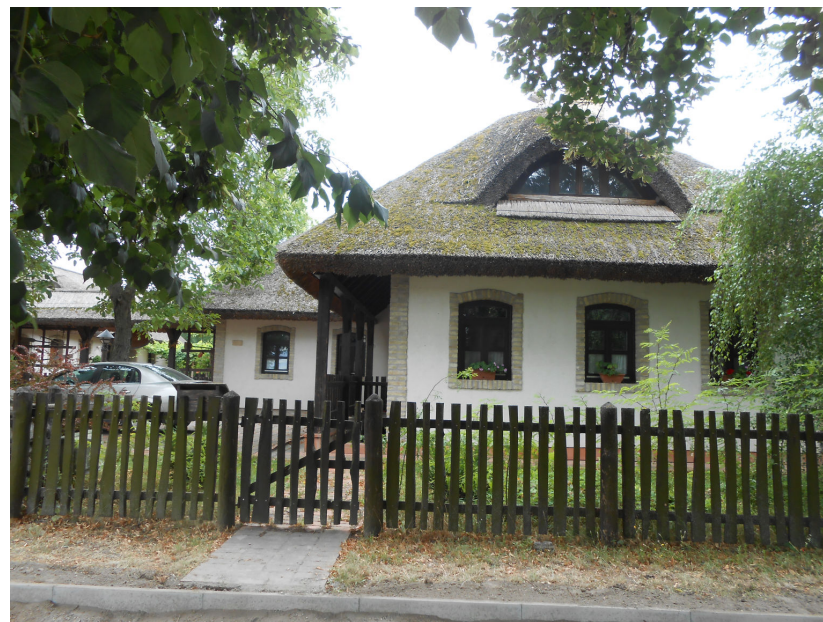
A funkciónak megfelelő (vendégház), a helyi sajátosságokat kiemelő formavilágú épület egyszerű kerítéssel, amely nem zárja el az épületet a külvilágtól.
