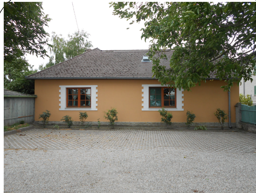
Egyszerű formájú épület, az ablakok keretezése hangsúlyos elemként jelenik meg.
